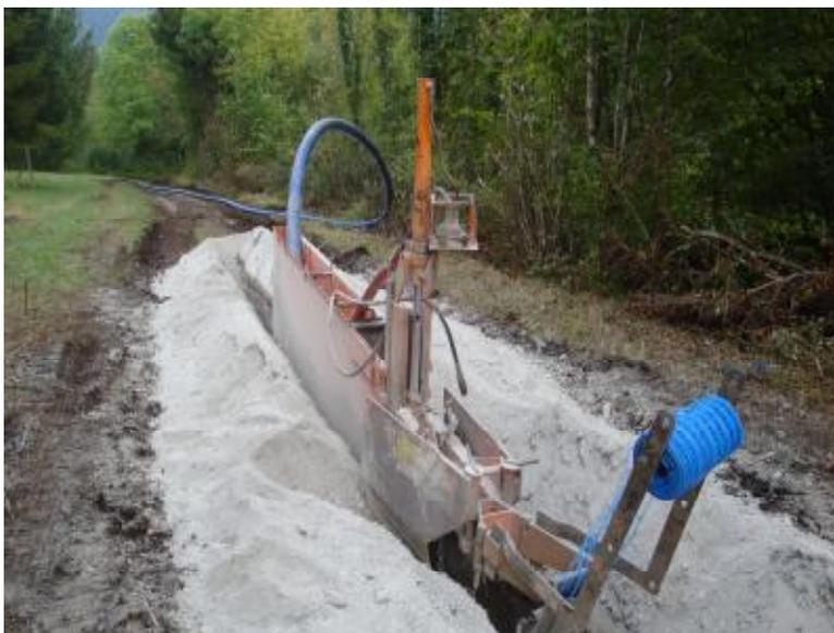
Pour régler ce problème et éviter les remarques récurrentes, les communes d'Echallon et de Plagne en collaboration avec la Communauté de Communes d'Oyonnax ont décidé d'entreprendre des travaux. Une conduite enterrée de 102 mm de diamètre en PEHD (polyéthylène haute densité) alimentera en eau et par gravité les habitants de Plagne depuis le réservoir situé sur la Fluaz.
